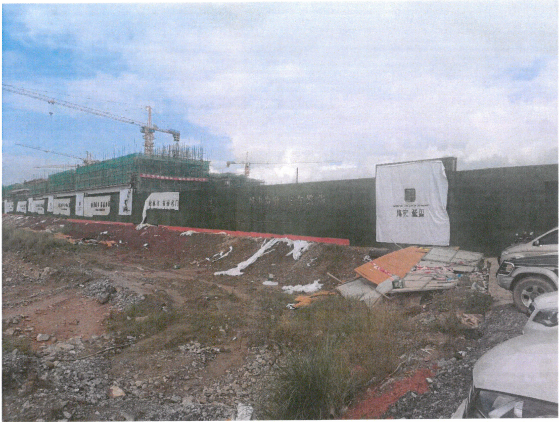
滨江御园一期工程整改后照片：
