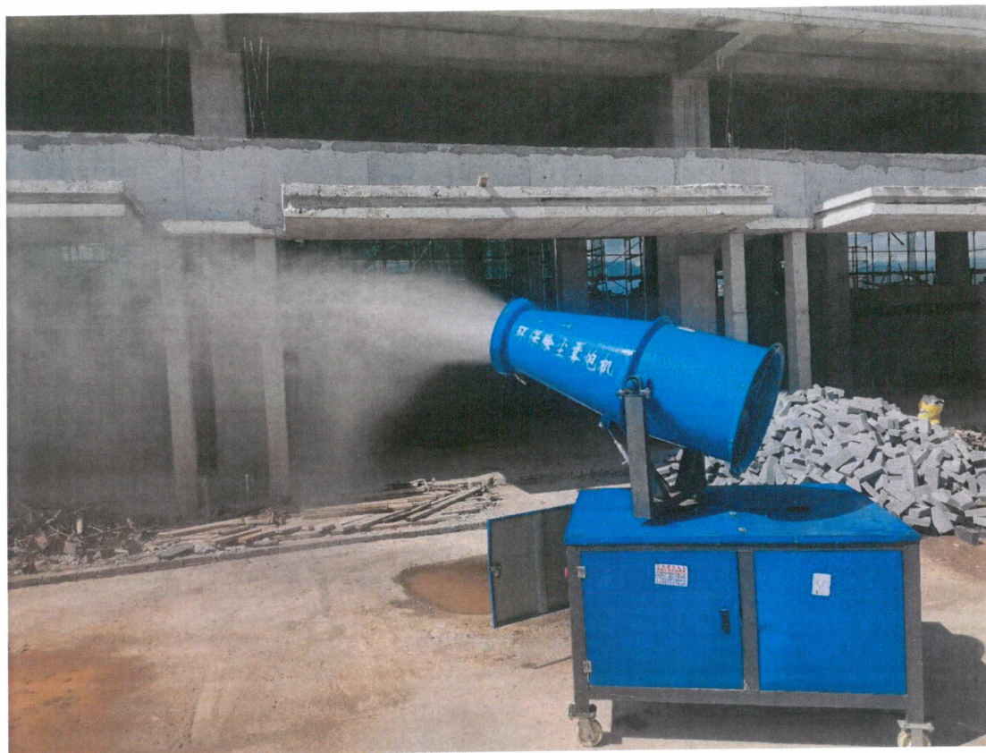
滨江御园一期工程整改后照片：
