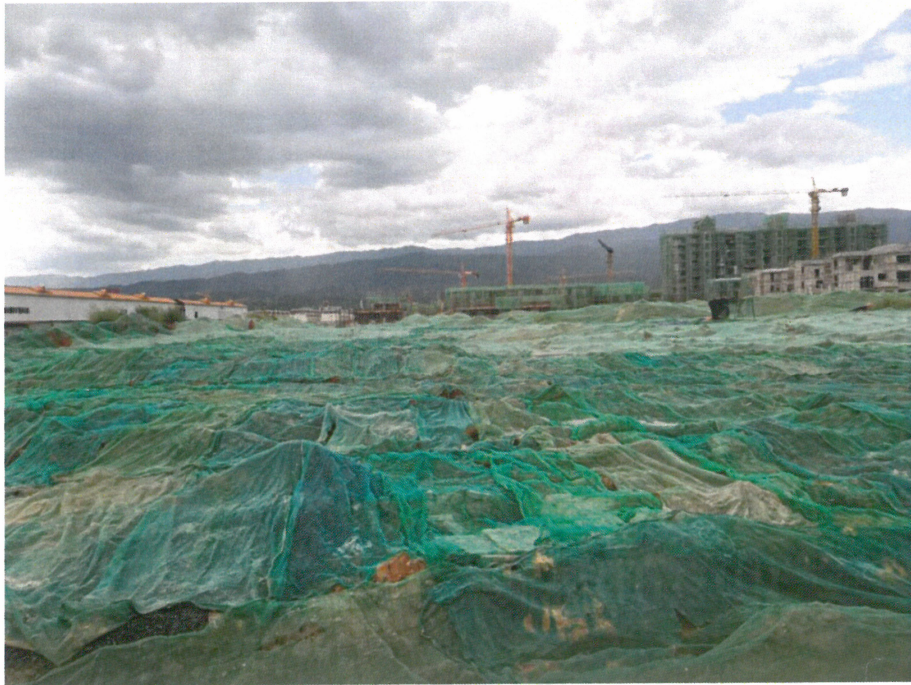
待建场地裸土覆盖
