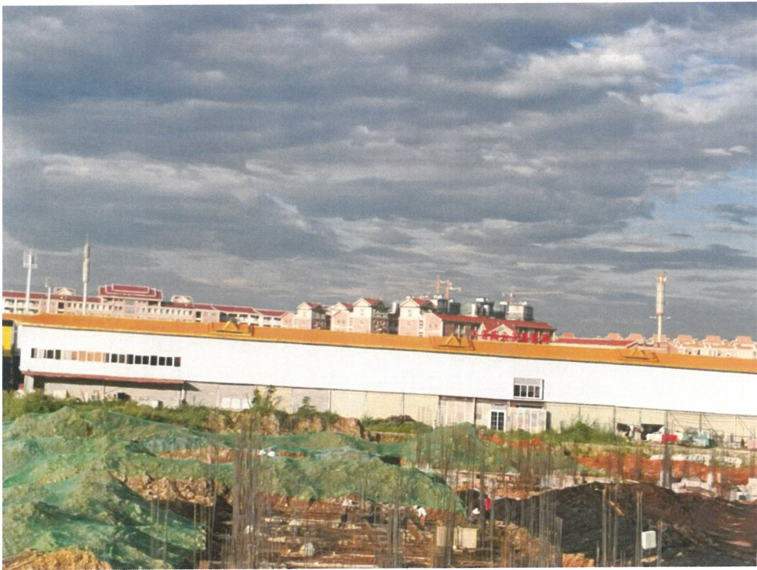
施工区土方覆盖
