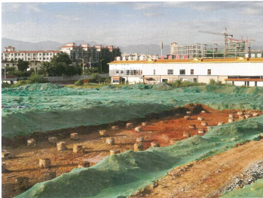
已开挖基础土方覆盖
