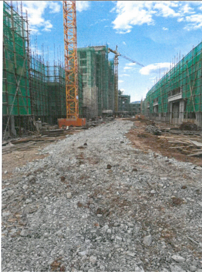
已硬化的辅路路面修复
