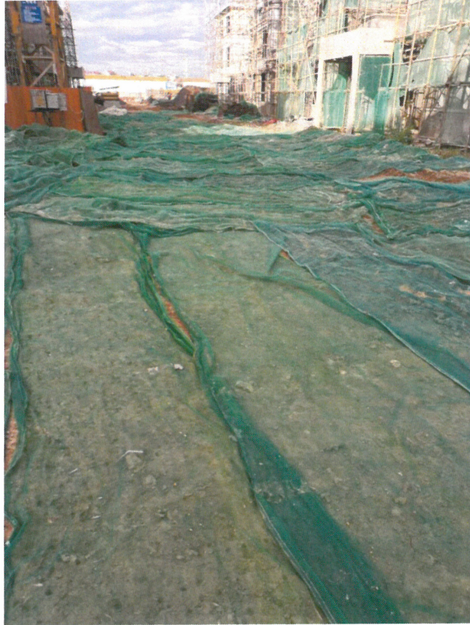
施工区闲置场地覆盖
