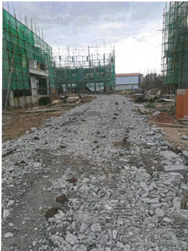
已硬化的辅路路面修复
