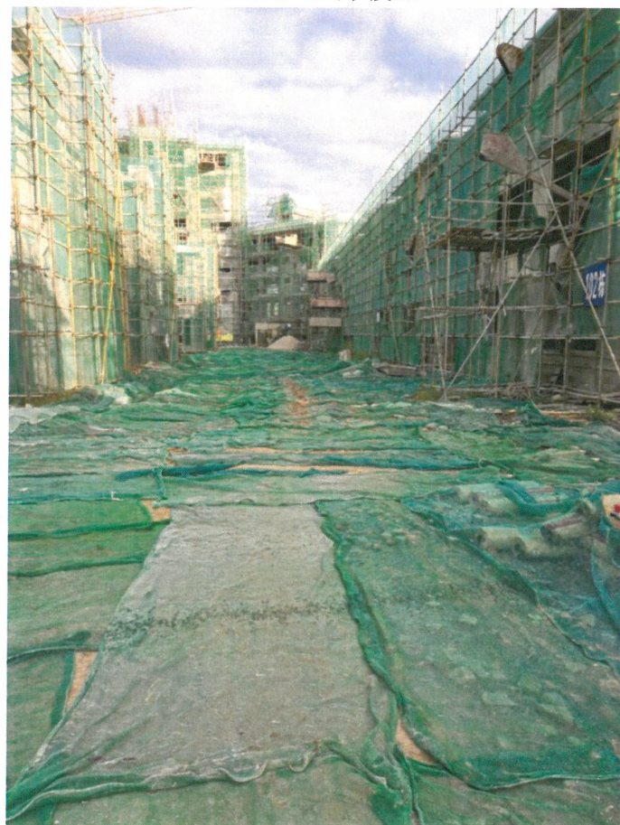
施工区闲置场地覆盖
