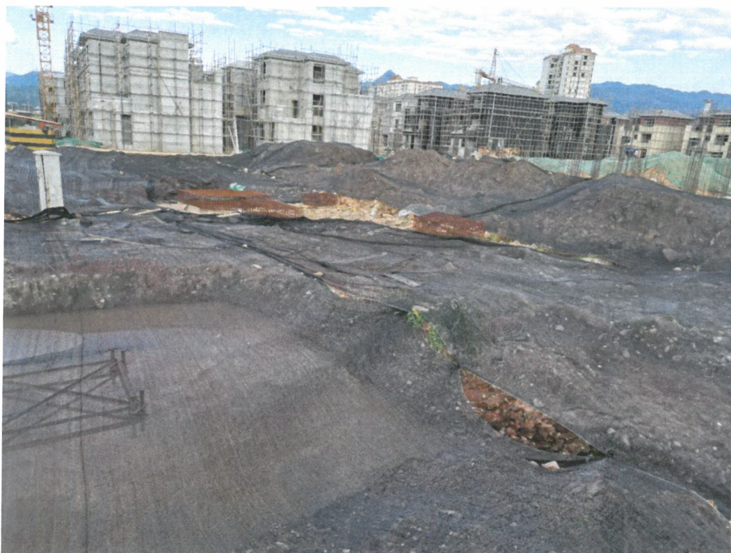
施工区土方覆盖
