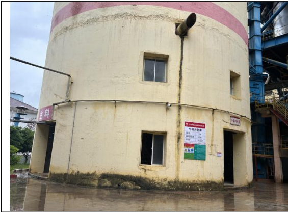
生料均化库 拍摄于 2024 年 11 月 7 日
