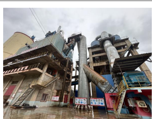
项目现场 拍摄于 2024 年 11 月 7 日
