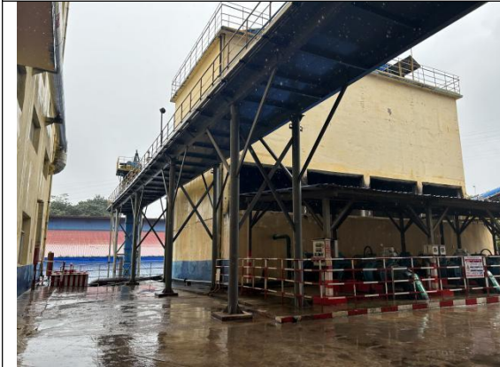
项目现场 拍摄于 2024 年 11 月 7 日
