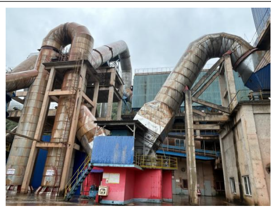
项目现场 拍摄于 2024 年 11 月 7 日
