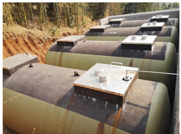
自来水储罐区
