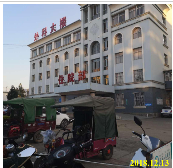
项目区西面（外科大楼）
