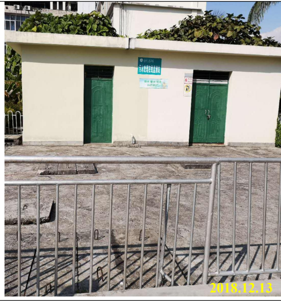
项目区西北面（污水处理站）
