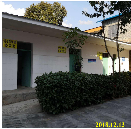
项目区西南面（医疗废物暂存点）
