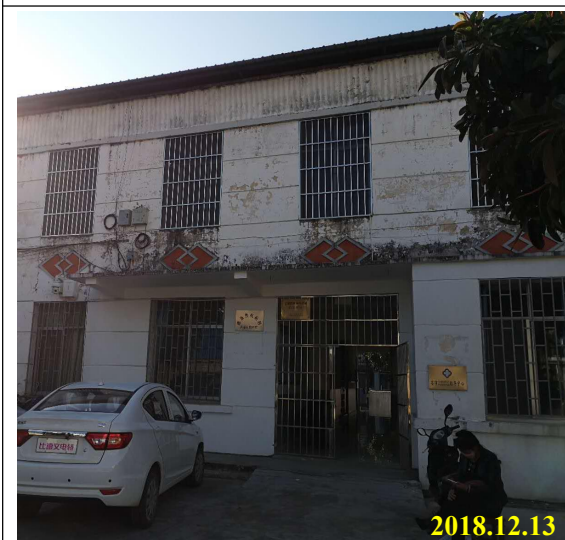
项目区西面（感染科，即将拆除）
