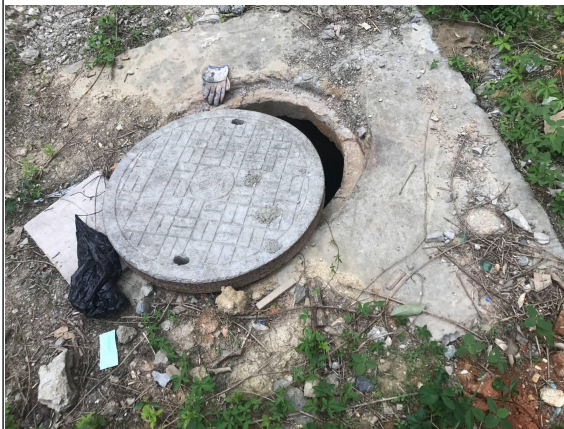
项目周边市政污水管现状
