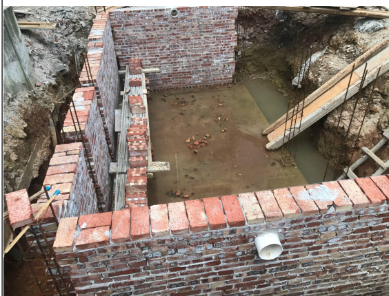
项目化粪池在建
