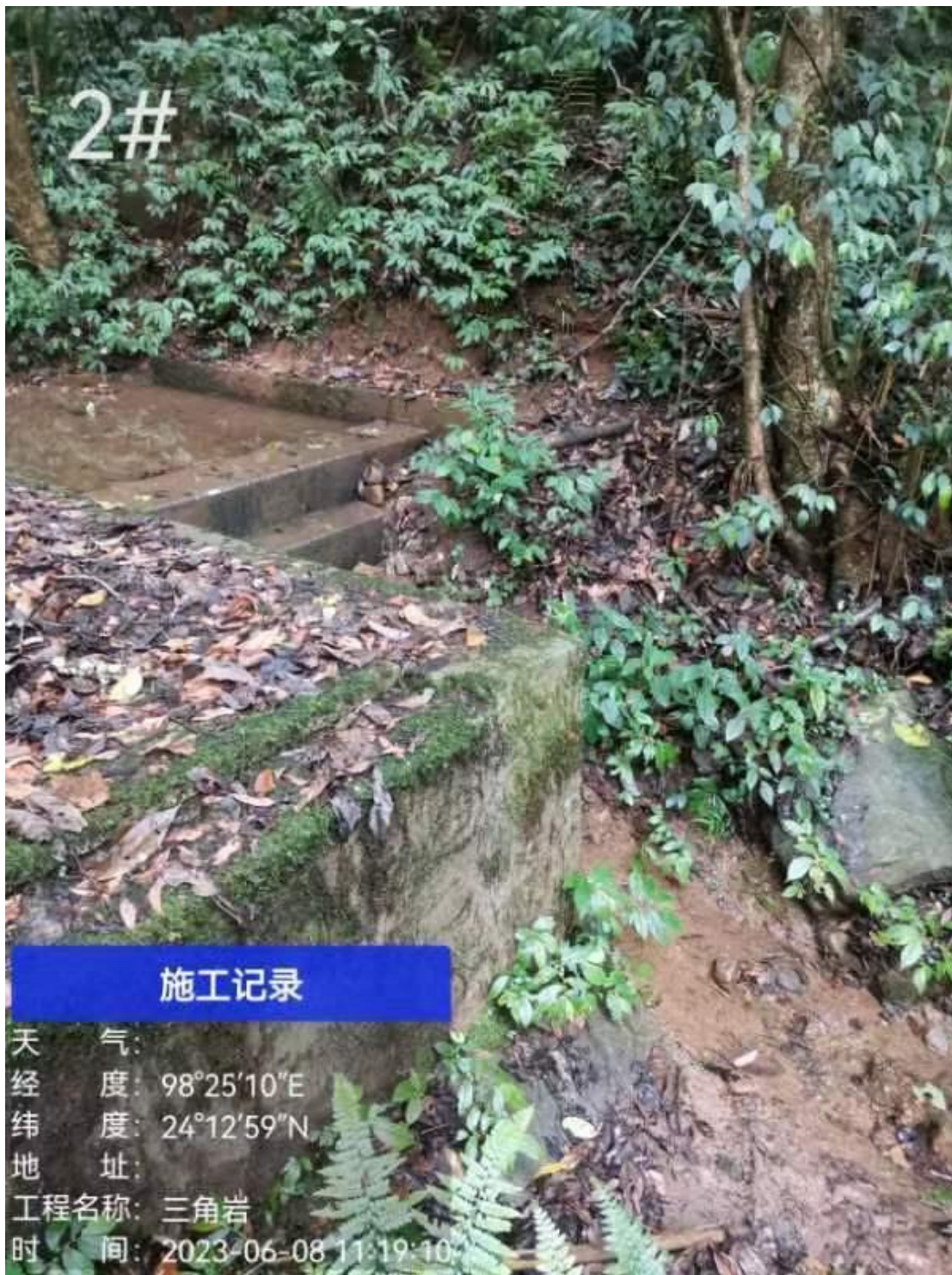
2#水源点取水口现状照片
