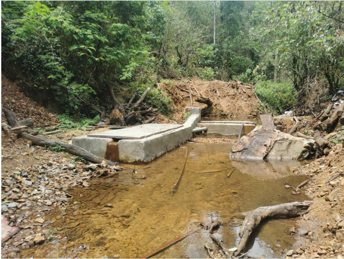
水源点取水口现状照片
